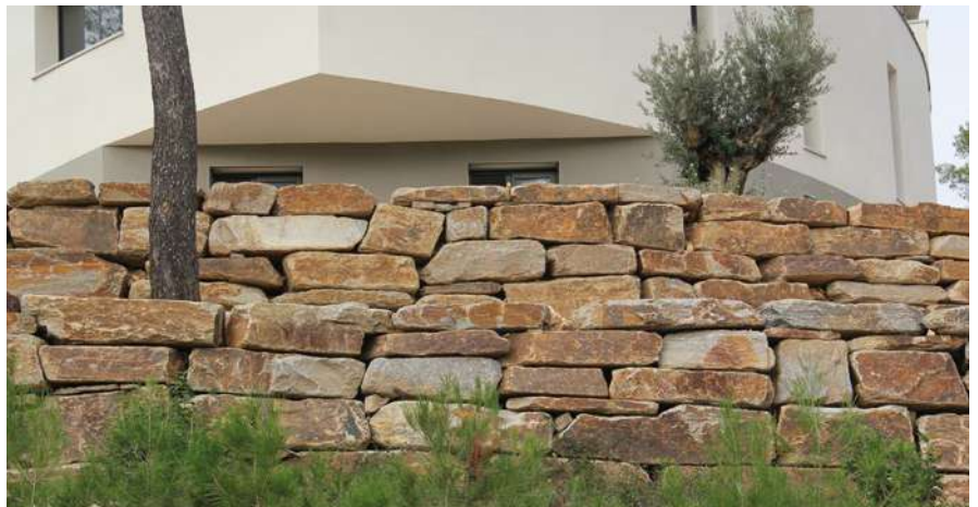
Enrochement Gneiss du Caroux
