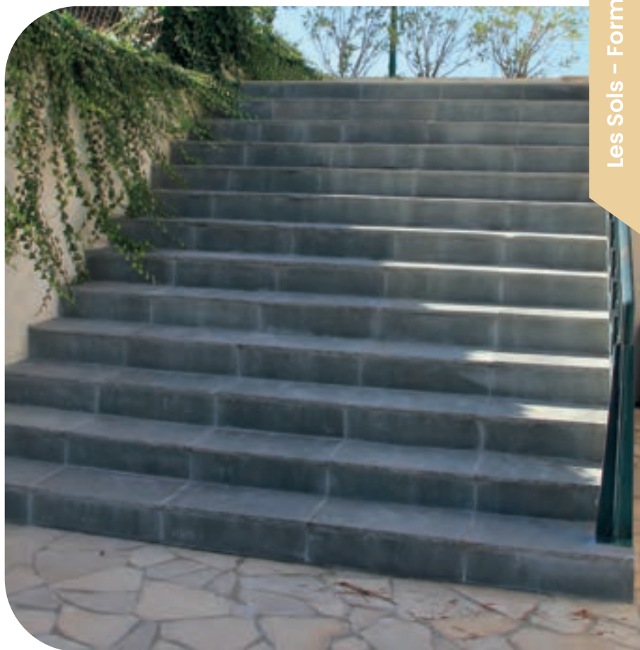
Escalier en dalles Bombay Grey
